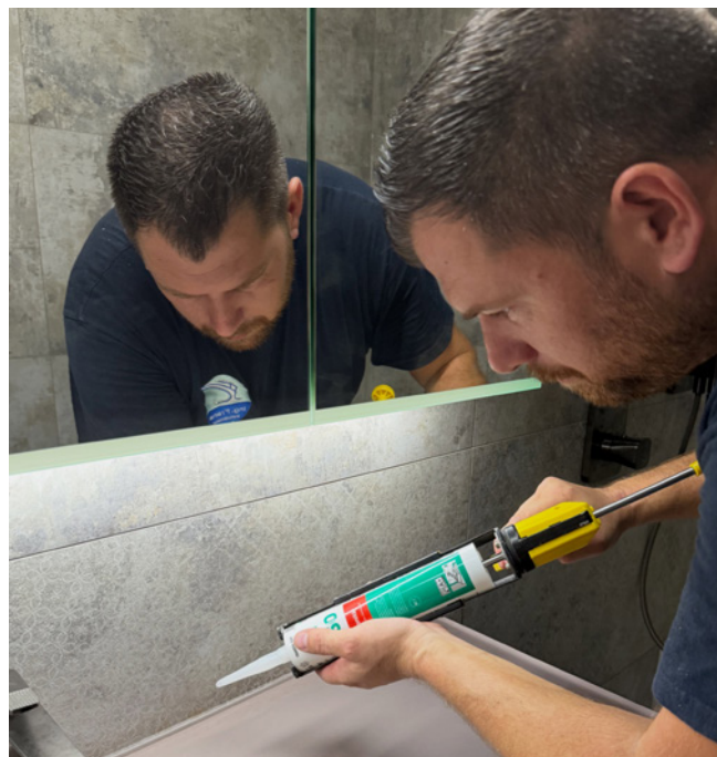
Sorgfält bis ins Detail: #1AINSTALLATEUR Frana setzt bei der Badmodernisierung auf präzise und saubere Arbeit.
