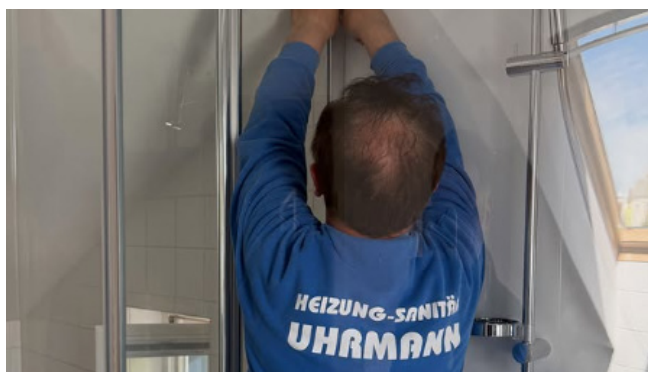
Individuelle Badlösung unter der Dachschräge: #1AINSTALLATEUR Uhrmann modernisiert den Duschbereich für mehr Komfort und Hygiene.
