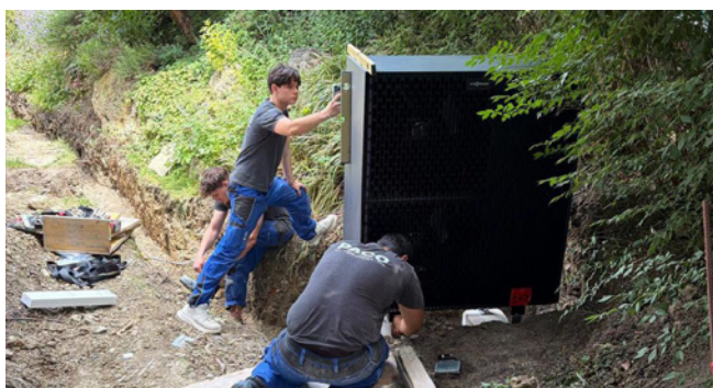
Millimeterarbeit beim Einbau: Bei #1AINSTALLATEUR Paco zählt bei der Wärmepumpenmontage der richtige Aufstellort.
