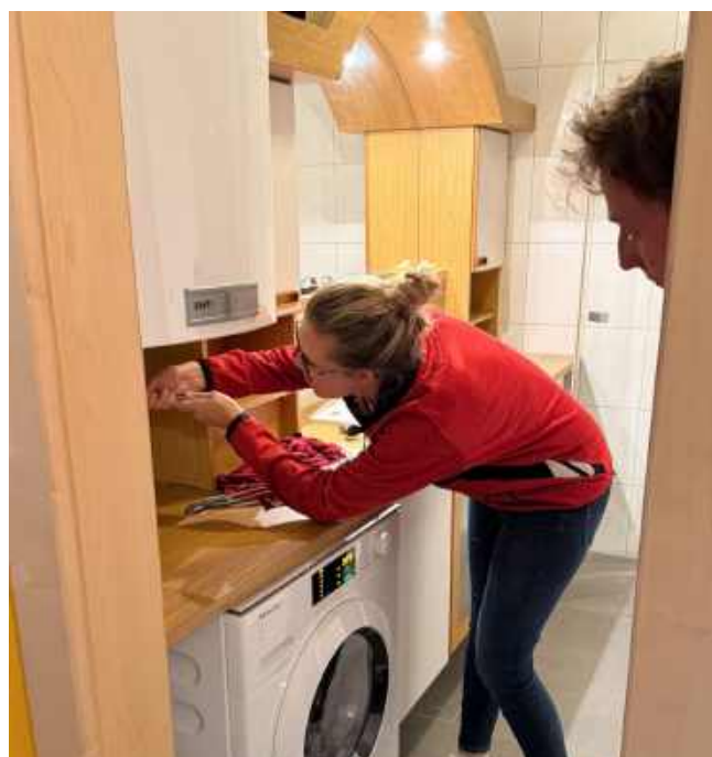
Die Bürochefin von #1AINSTALLATEUR Erhart beherrscht nicht nur den Computer und das Telefon, sondern kann auch mit anpacken!
