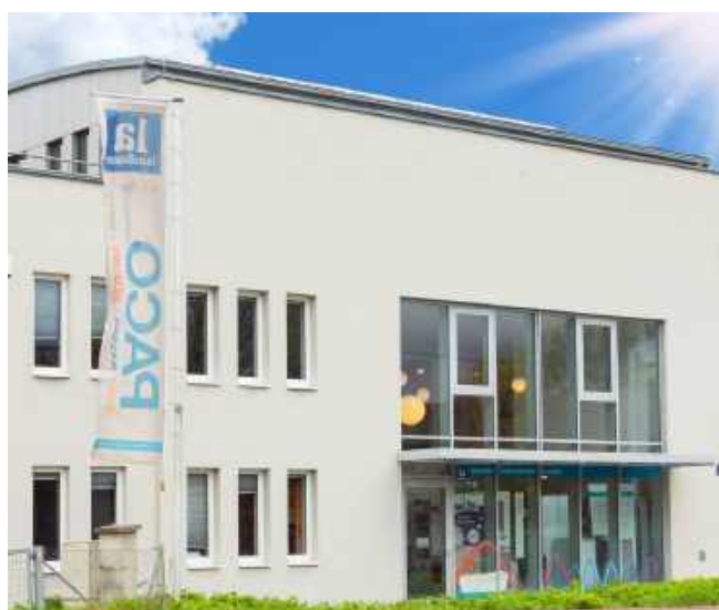
Diesen Schnappschuss vom Firmengebäude mit neuer 1a-Auslagenbeklebung postete #1aINSTALLATEUR Paco aus Wien-Hütteldorf.
