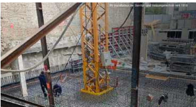
Baustellen-Schnappschuss: Bei #1AINSTALLATEUR Sonderhof in Wien-Floridsdorf nimmt das neue Bürogebäude langsam Form an.
