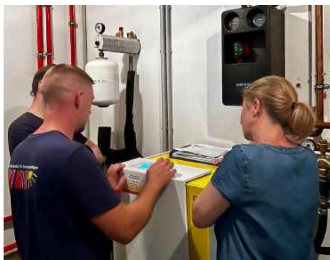
Bei #1aINSTALLATEUR Weissinger wurde unter der Aufsicht des Chefs den Kunden die neue Wärmepumpe ausführlich und genau erklärt.
