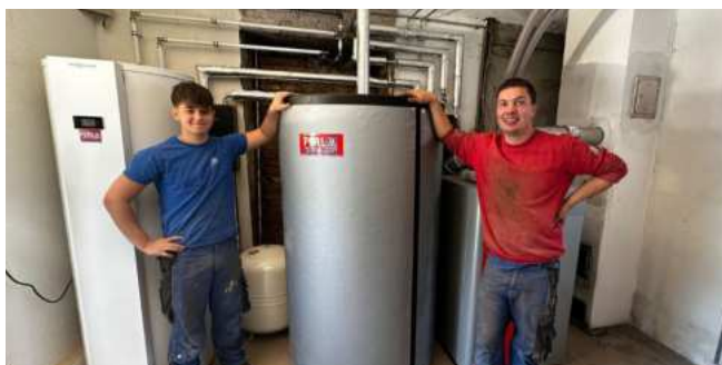
Das Team von #1AINSTALLATEUR Perl hat erfolgreich von Gas auf Pellets umgestellt.
